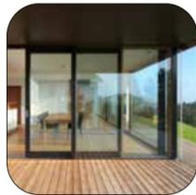
Flügel befindet sich im geschlossenen Zustand hinter dem Kämpfer, daher mehr Glaslichte.
